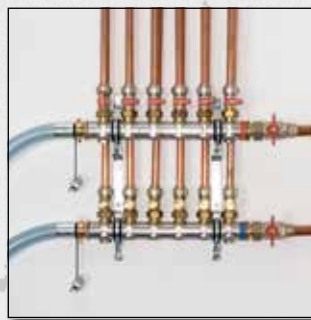
Spülen von Radiatoren- und Flächenheizsystemen (S/SL/SLW)
